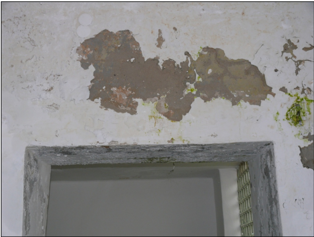
Ściany, słupy i strop piętro segmentu R
