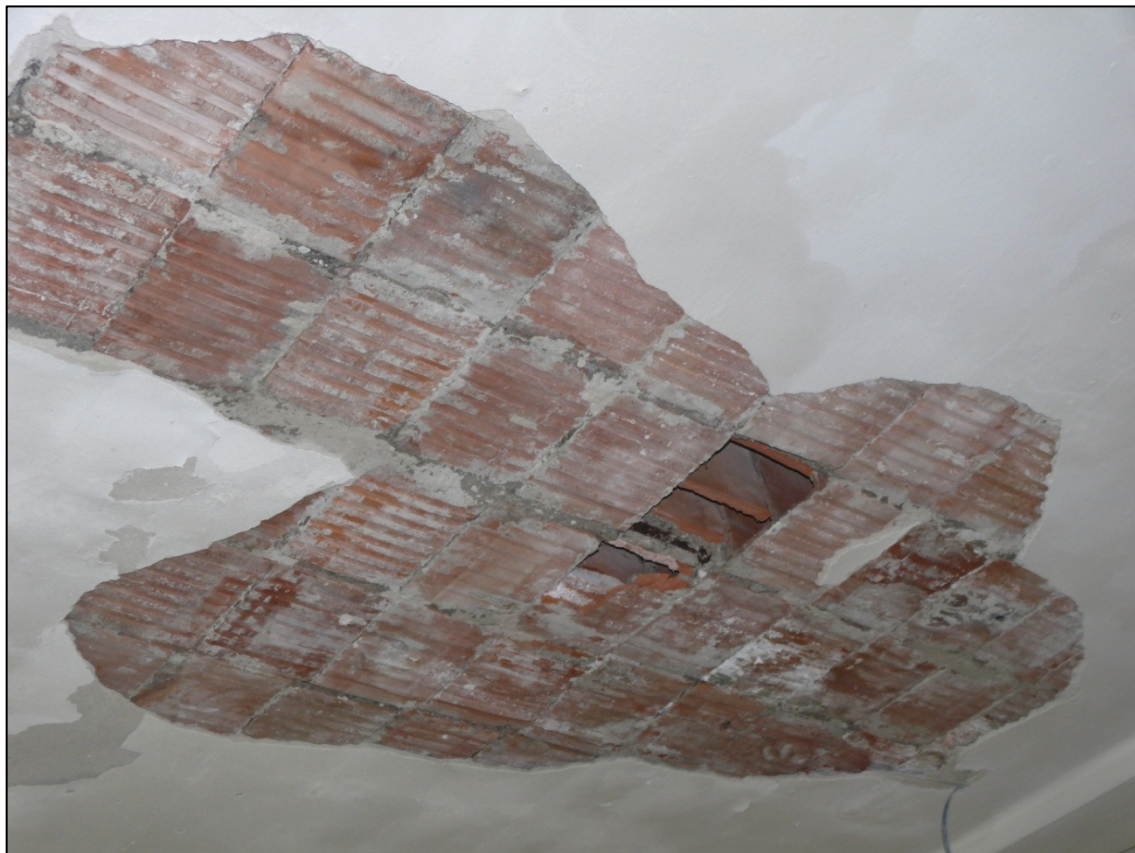
Uszkodzony strop nad piętnem w segmencie N
