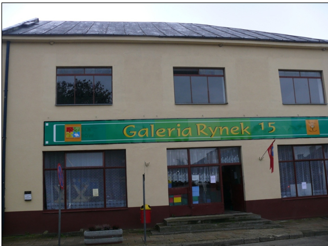
Widok na budynek R od strony Rynku
