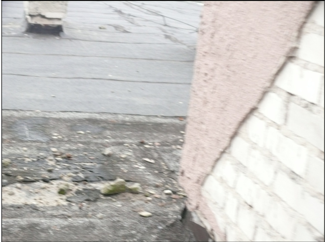
Dach segmentu N
