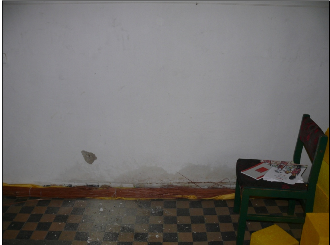
Wnętrze parteru budynku R
