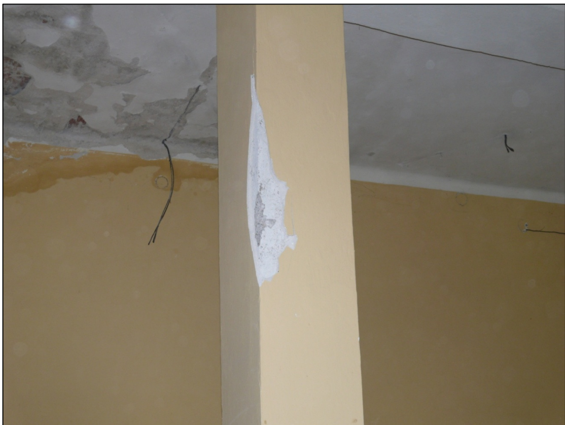
Ściana, strop i słup pietra segmentu N
