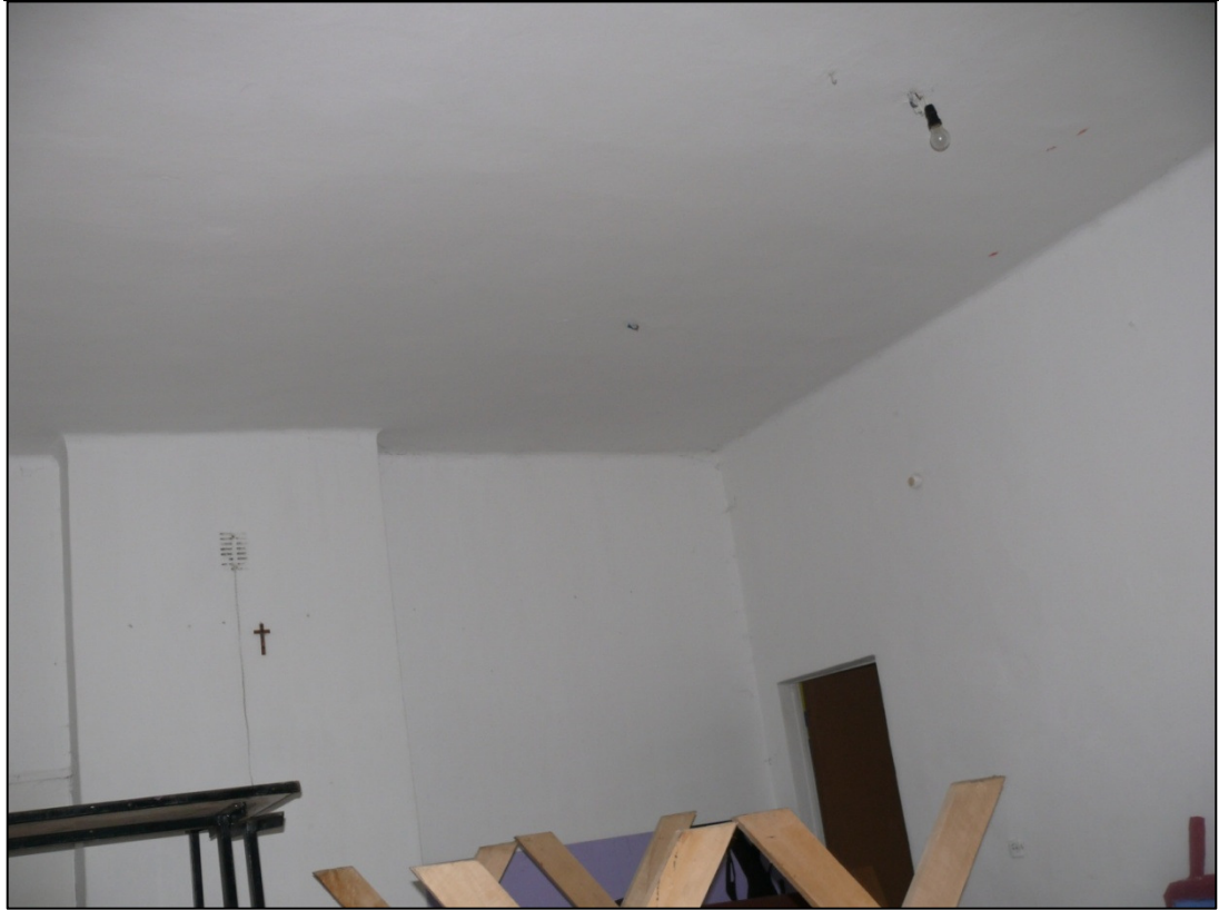
Wnętrze parteru budynku R
