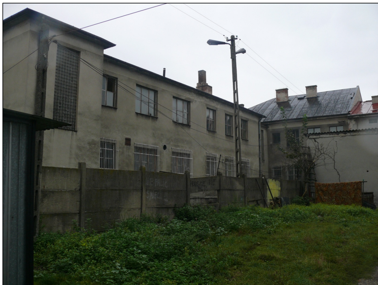
Elewacja tylna budynku N i R
