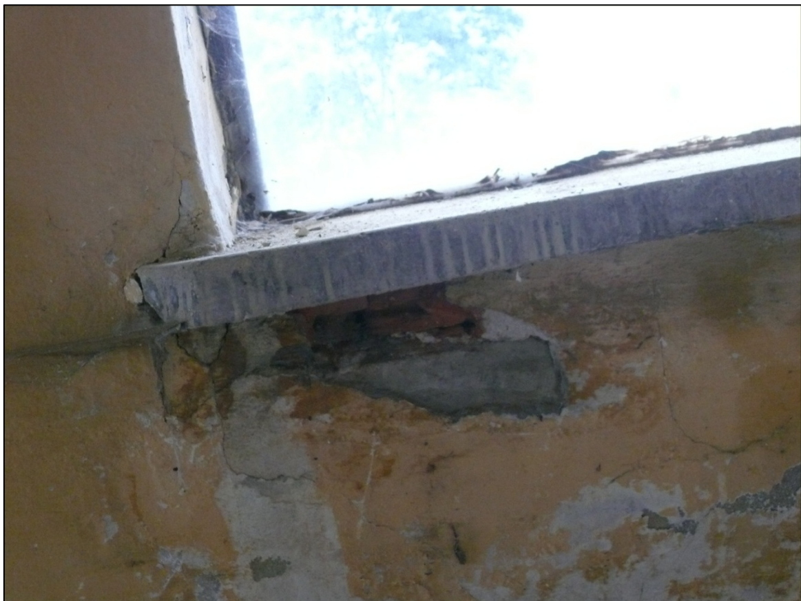
Ściana pietra segmentu N
