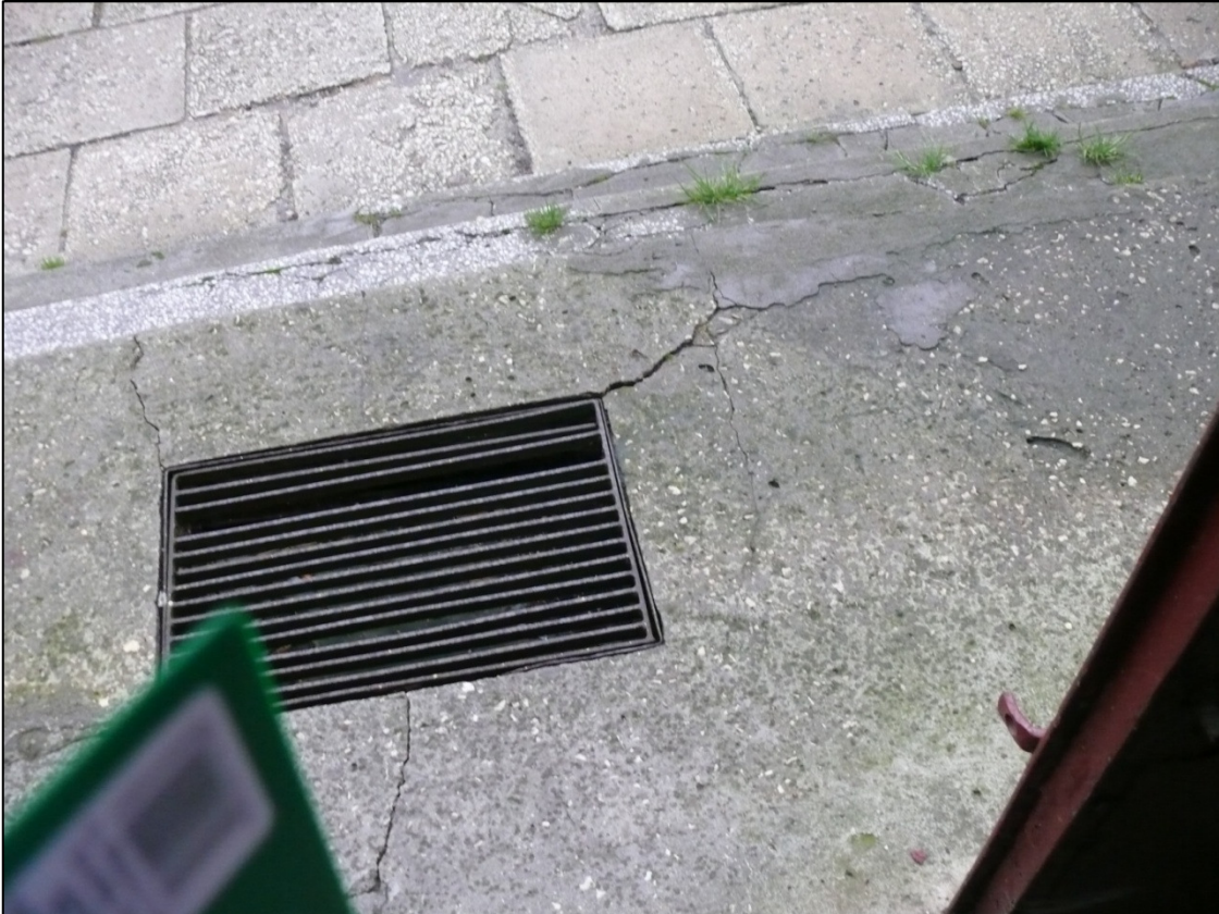
Chodnik przed budynkiem R
