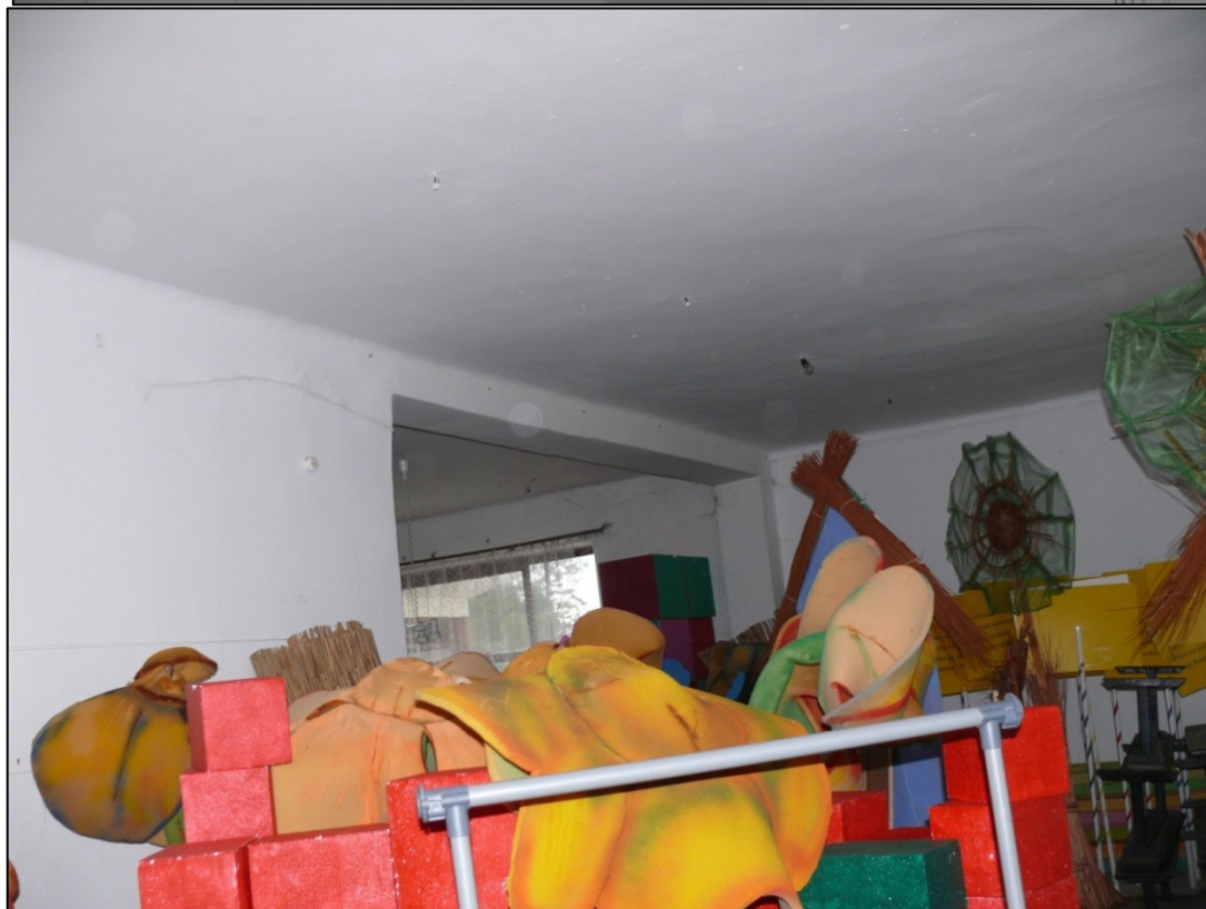
Wnętrze parteru budynku R
