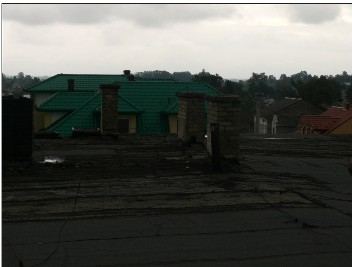
Dach segmentu N
