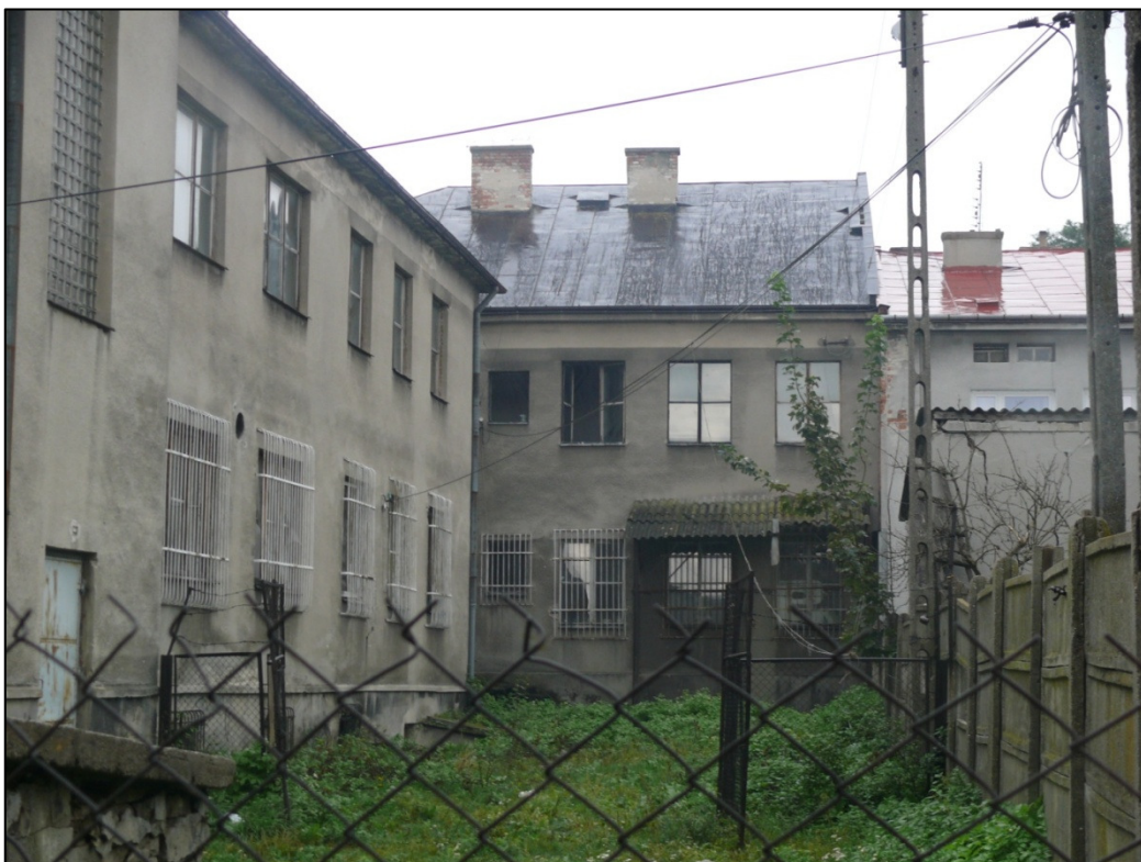
Elewacja tylna budynku N i R
