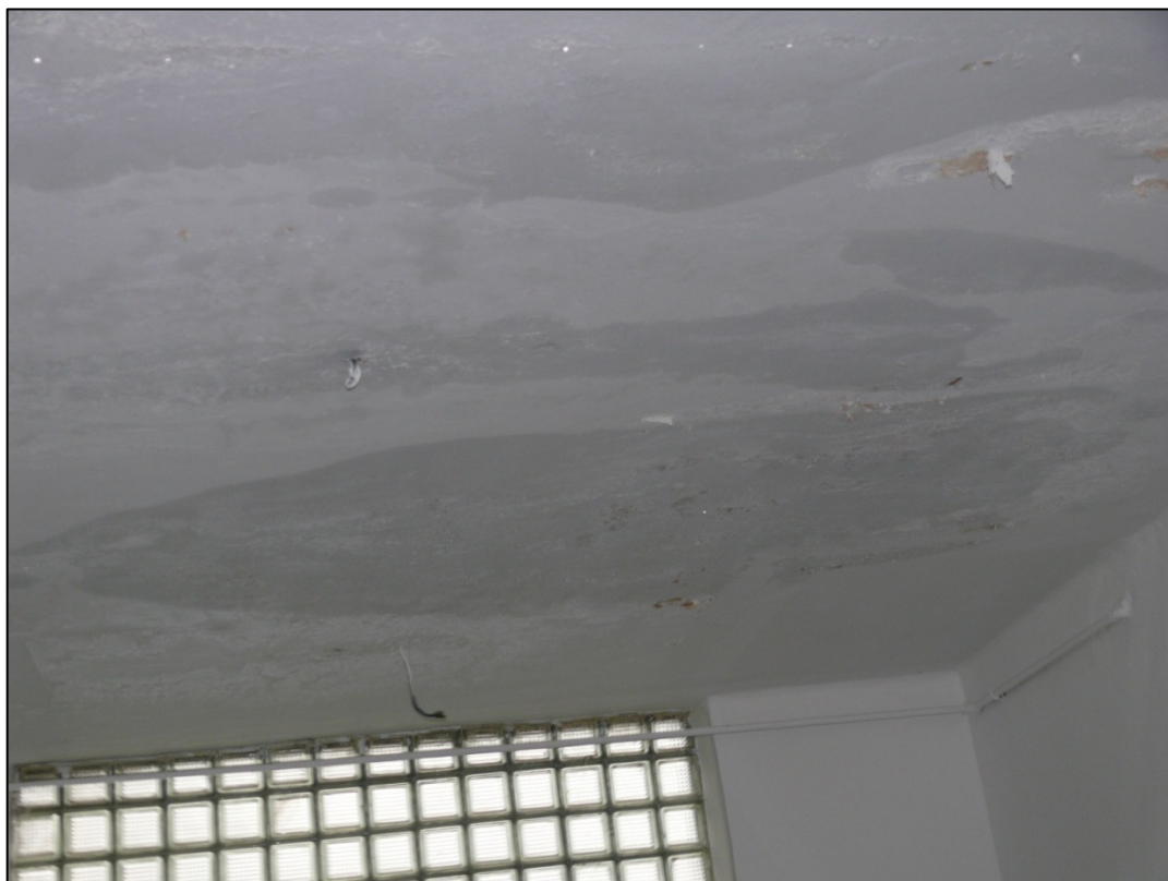
Strop piętro segmentu R
