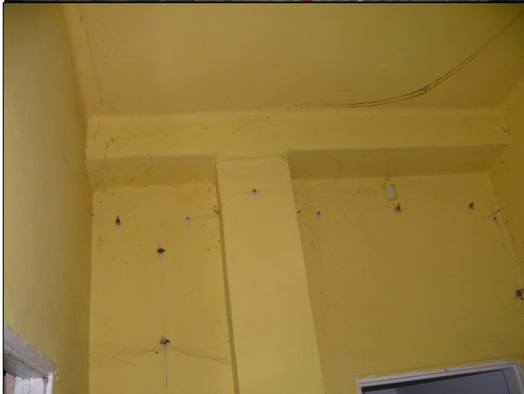
Wnętrze parteru budynku R
