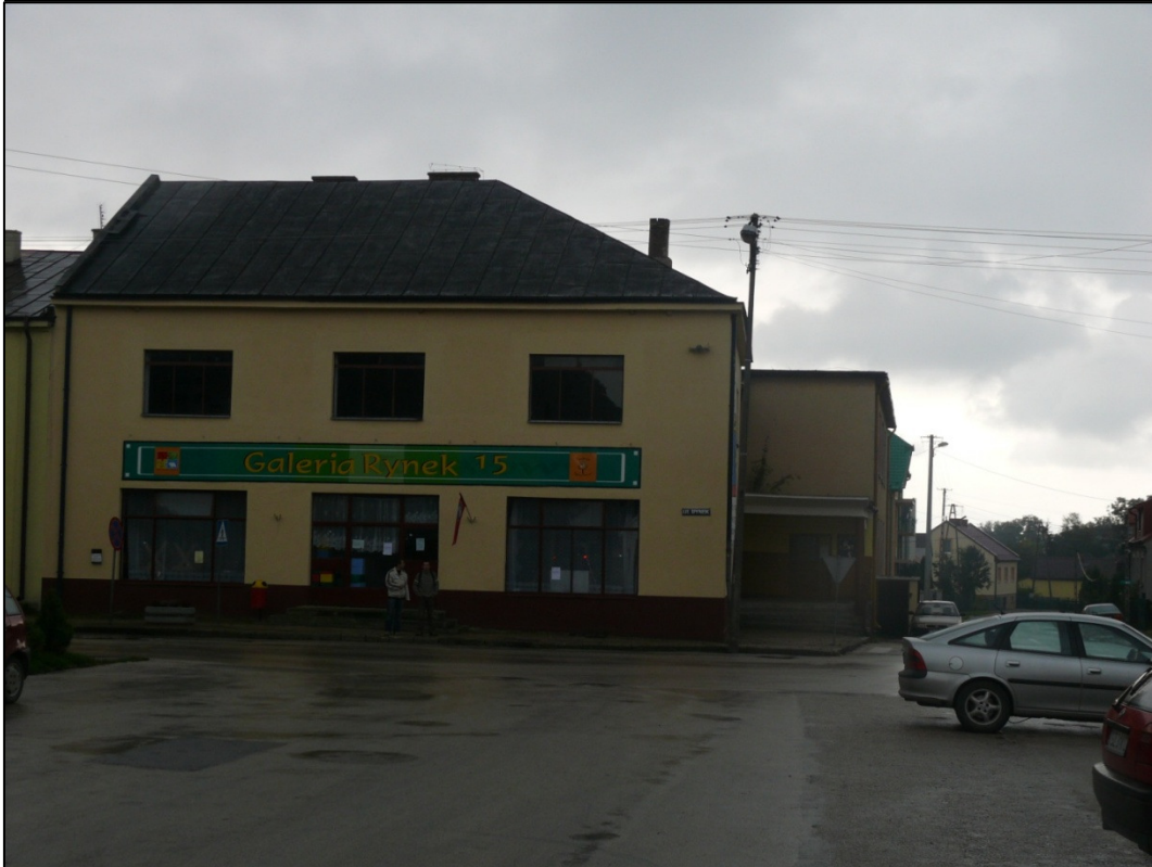
Widok na budynek R od strony Rynku
