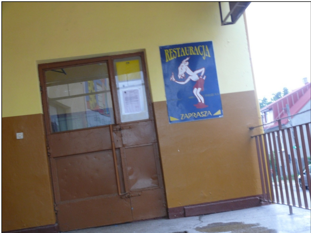
Wejście do segmentu N
