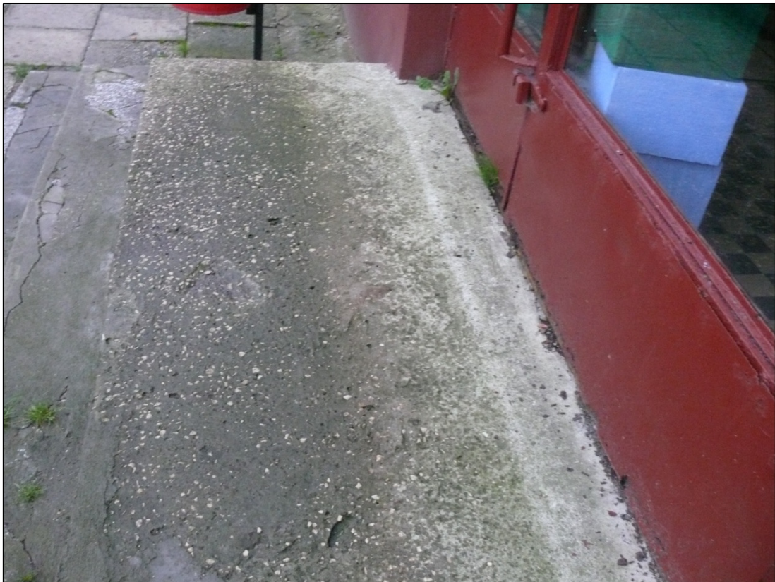
Chodnik przed budynkiem R
